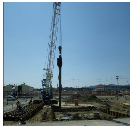
既設構造物撤去のための鋼矢板打込み状況
